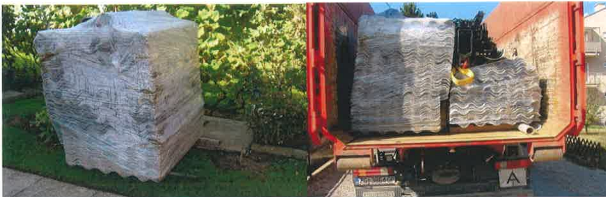
Slika br.1. Prikaz zbrinjavanja azbestnih ploča s područja Grada
